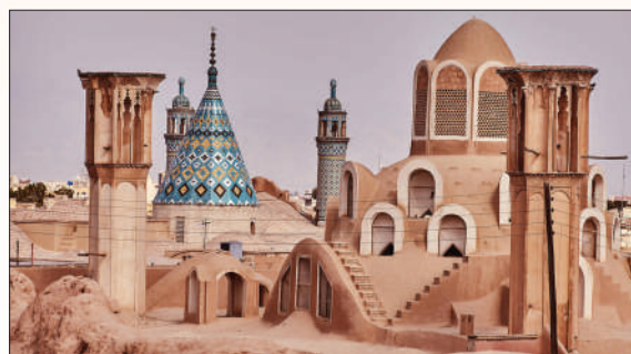
سقف خانه تاریخی بروجردی و برج های تهویه.
